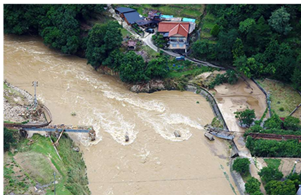
③JR芸備線 (白木山駅～狩留家駅間 第1三篠川橋)
