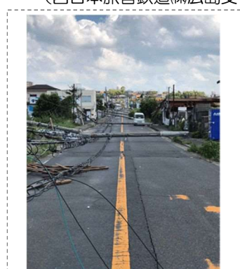
平成30年の台風21号による電柱倒壊 (大阪府泉南市) 〔引用：令和元年版 防災白書 (内閣府 HP) http://www.bousai.go.jp/kaigirep/hakusho/h31/photo/ph011.html 〕
