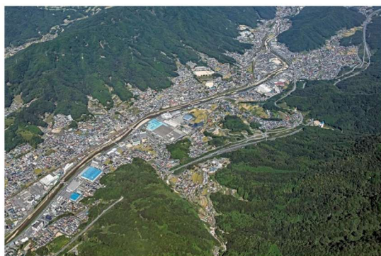
一般国道2号(現道, 東広島バイパス)
