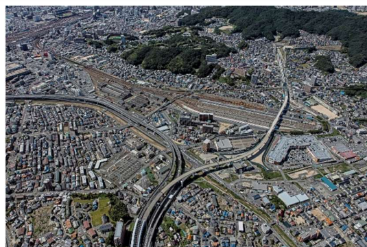
広島高速道路 1号線, 2号線, 5号線(建設中)
