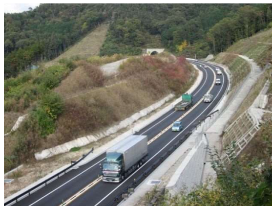
一般国道2号 東広島バイパスの様子 〔写真提供：国土交通省 広島国道事務所〕
