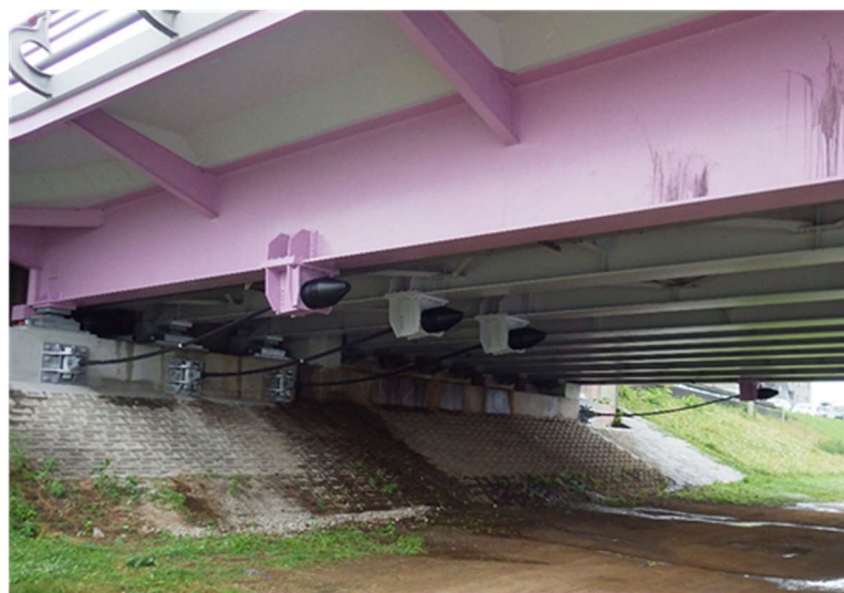
橋りょうの耐震化（新己斐橋 落橋防止装置の設置）
