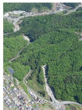
一般国道433号(大古谷トンネル, 川角トンネル)
