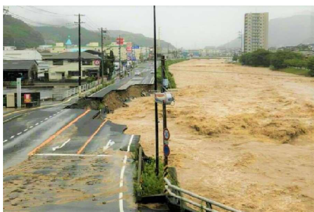
①国道2号 (広島市安芸区中野東)
