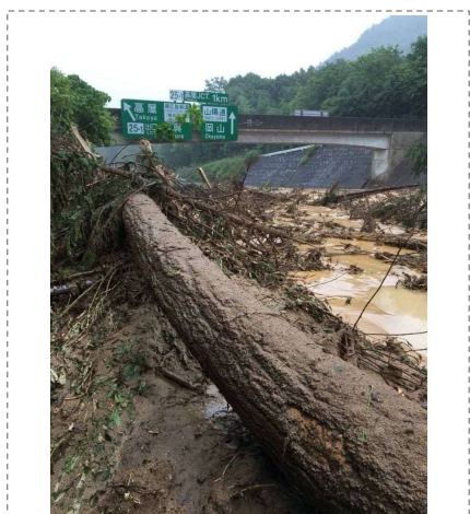
平成30年7月豪雨災害における 山陽自動車道の被災状況 〔写真提供：国土交通省 中国地方整備局〕
